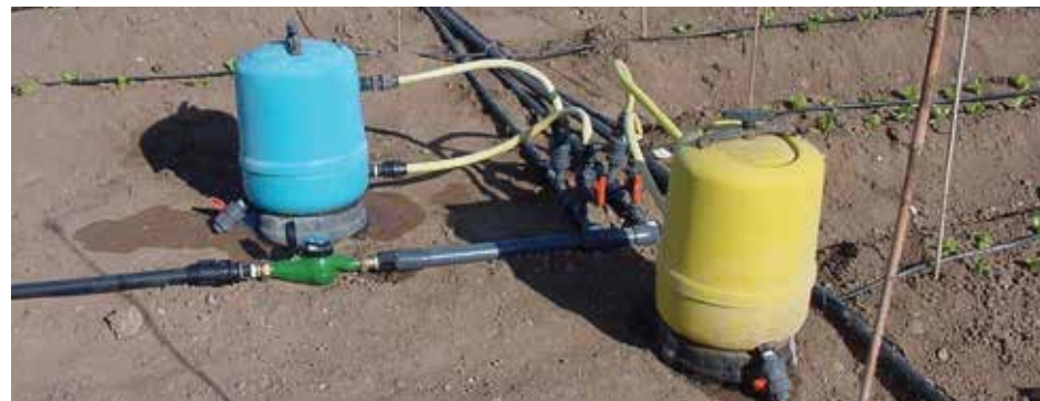
A tápoldatot nyomástartó tartályból elkerülő vezetéken kijuttató rendszer
