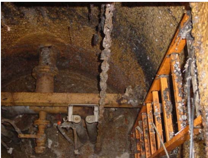
Beton- és fém alkatrészek korróziója
